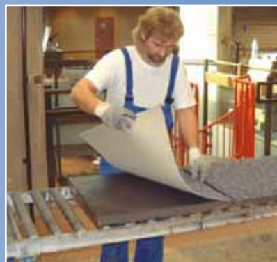
Der neue Teppichboden wird appliziert.
