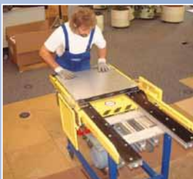
Der Kleber hat über Nacht abgedunsten. Der überstehende Teppichboden wird mit unserer Besäummaschine sauber, gleichmäßig und bündig mit der Doppelbodenkante abgeschnitten.
