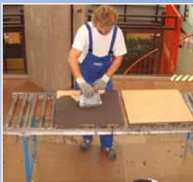
Der Klebstoff wird aufgetragen.
