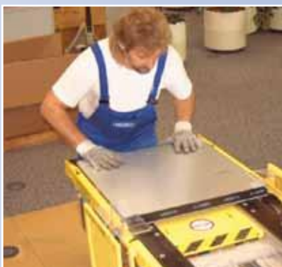
Überstehender Teppichboden wird abgeschnitten.
